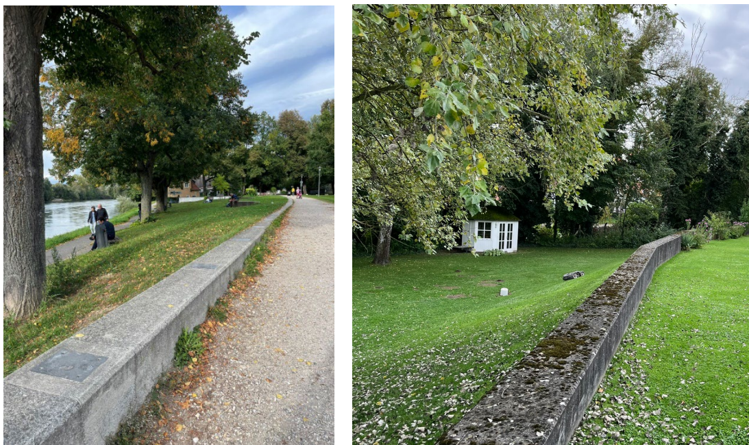
Foto 9 og 10: Bildet til venstre viser flomvoll med gress og vegetasjon tilknyttet turvei, Neuburg, Tyskland. Bildet til høyre viser gresskledd flomvoll tilgrenset boligbebyggelse, Neuburg, Tyskland.
