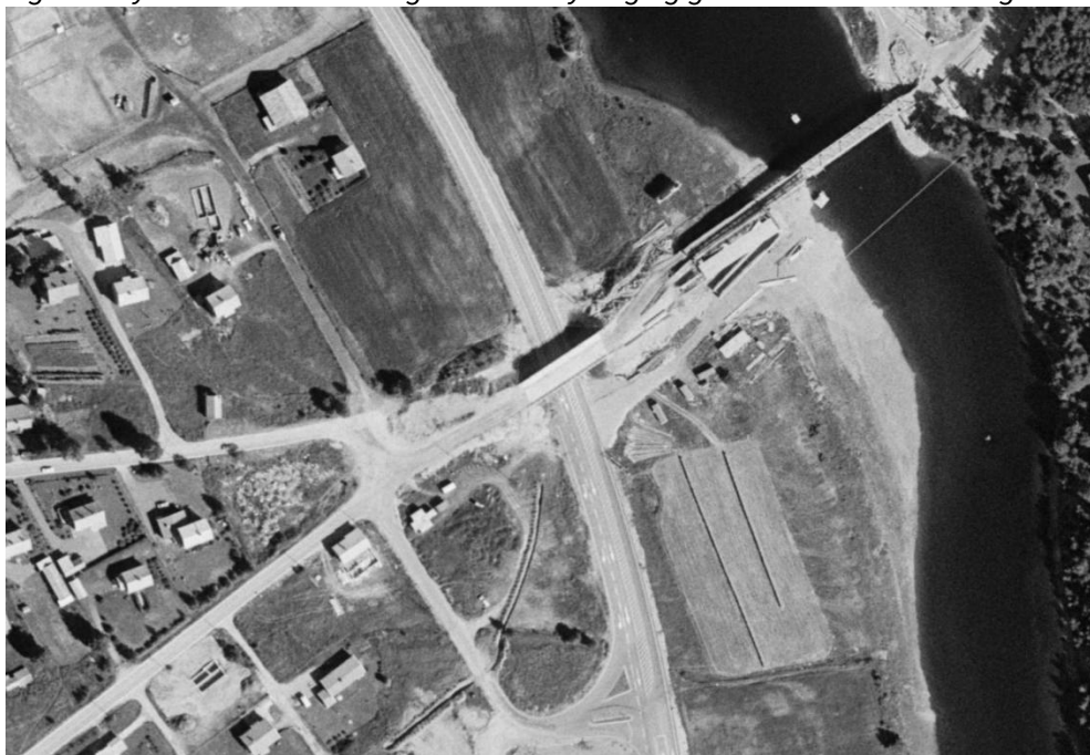
Figur 9: Riksveien og fylkesveibrua ferdig bygget, ny bru over elva under bygging på flyfoto fra 1972
