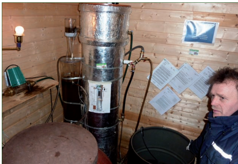
Til venstre: Eit bilete frå Fjærland der eit par bønder har laga eit metanutvinningsanlegg av rå kumøkk.
