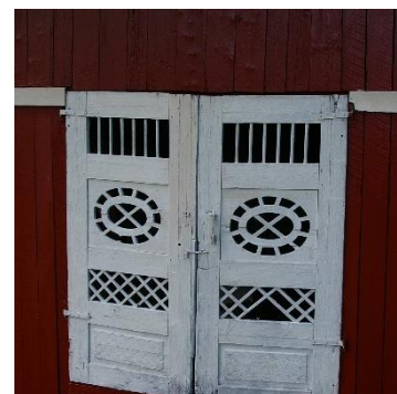
6-29 Sjøheim søndre. Dør i driftsbygningen.
