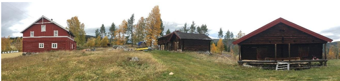
5-45 Del av tunet på Garnåshaugen gnr. 47/31 med stabbur, fjøs og stall til høyre og en nyere driftsbygning til venstre.
