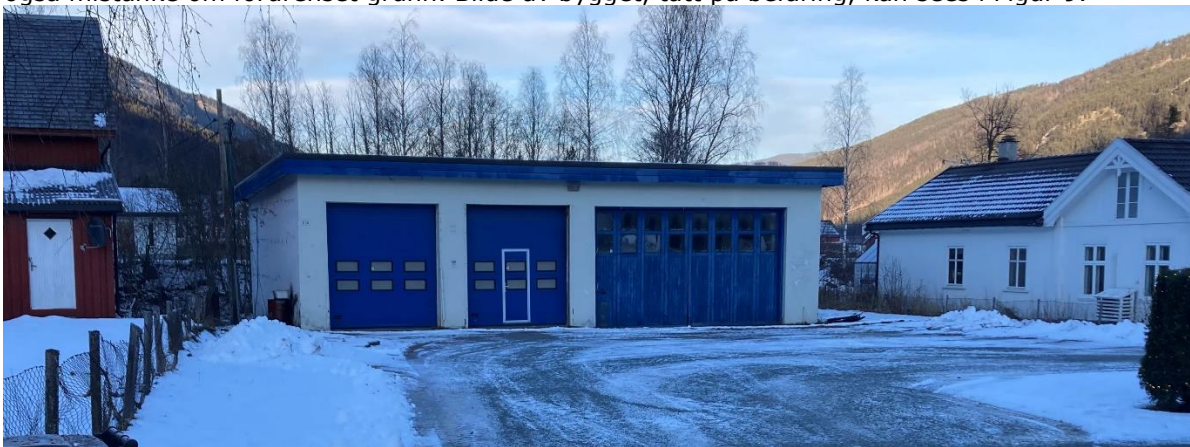
Figur 9: Bilde av antatt eldre verksted/garasje med mistanke om forurenset grunn. Foto: Rambøll, 4. desember 2024.
