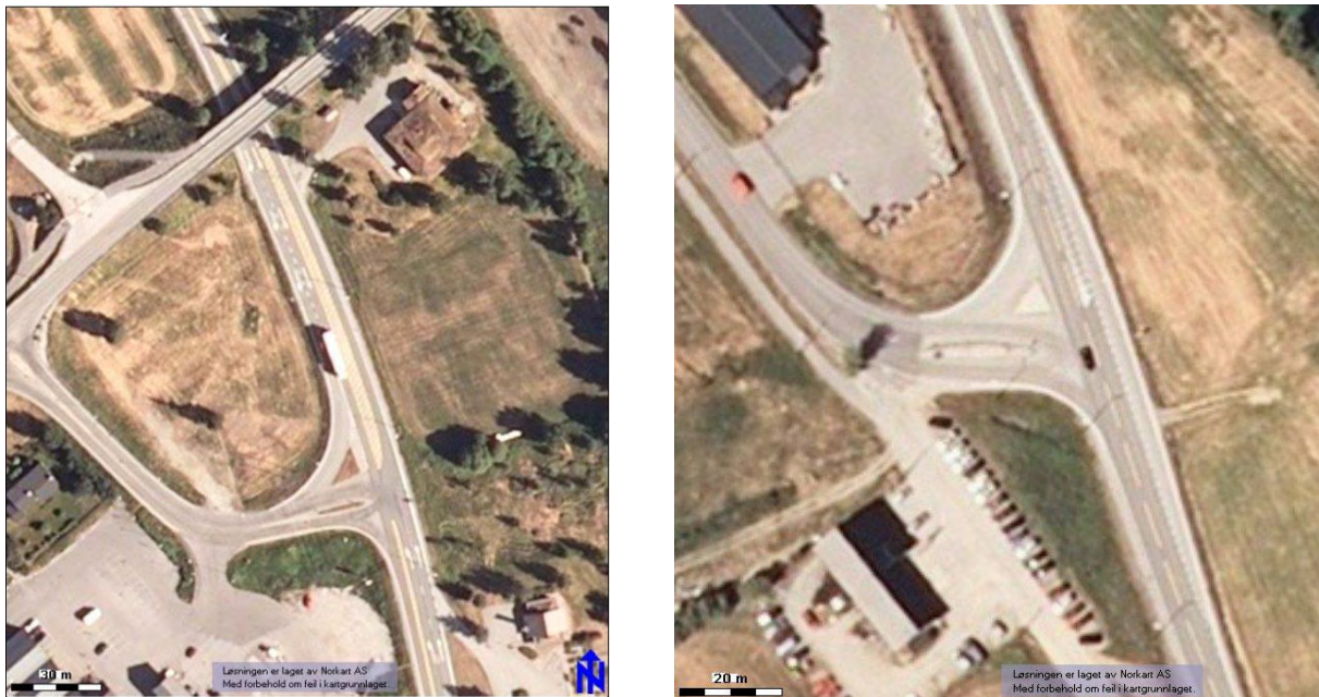
Figur 1-2 Dagens utforming av kryss med Rv 7 ved sentrum (venstre) og kryss med Rv 7, 2 km sør for sentrum. (høyre)
