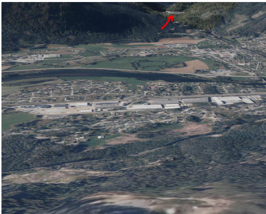
Figur 20. Oppe fra kanten av fjellet ved Trytetjern kan noe av den ferdige veggen i uttaket ses. Utsnittet er tatt der hvor flere av downhill sykkelstiene starter.
