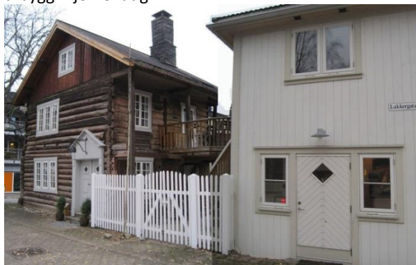
En tømmerbygning fra 1670-årene bundet sammen med en ny bygningskropp fra 2006 i funkisstil. Bjørnsenhuset.
