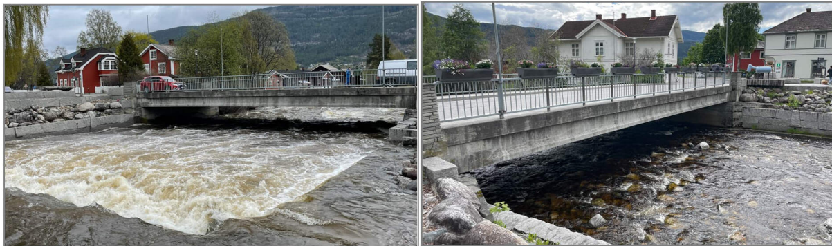
Figur 3.3: Hajem bru sett fra oppstrøms, 07.05.2024 og 19.06.2024
