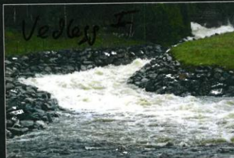
Plastring av kantene der kanalen kommer ut i Borgåa
