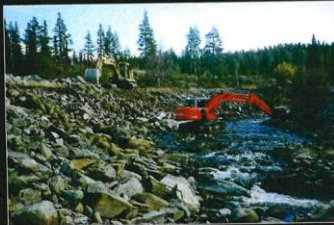
Dozerdrift i arbeid ved kanalen ned mot Åmottjern på 1980-tallet
