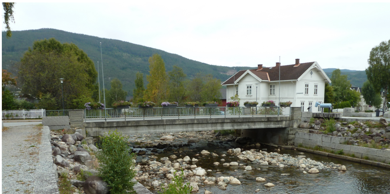
Figur 28. Eksisterende Hajem bru. Bildet er tatt 27. august 2025.
