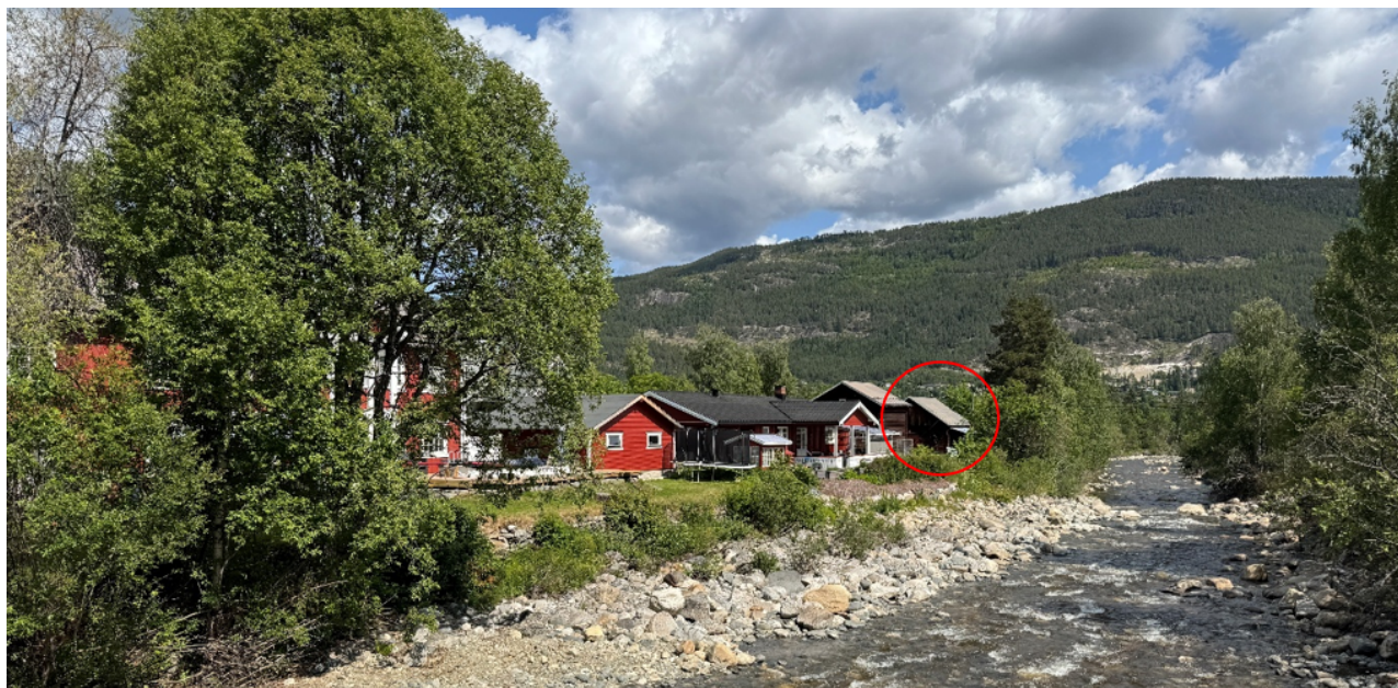
Figur 47. Det markerte vedskjulet på Bruvollen kan få nærføring av tiltaket.
