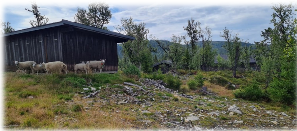
FIGUR 10: GARASJEN ER BYGGET FOR MASKINER OG REDSKAP KNYTTET TIL LØYPEKJØRING
