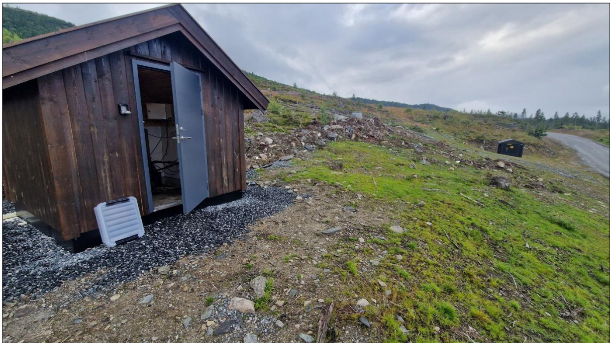
Figur 8. Vannbehandlingsbygg ved Sundbolien størrelse 2,5 x 3 meter
